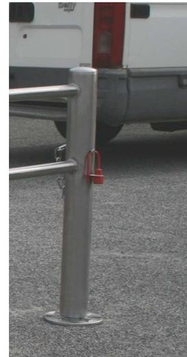
Fermeture sur le poteau principal par tige traversante et cadenas pompier ici (en option)
