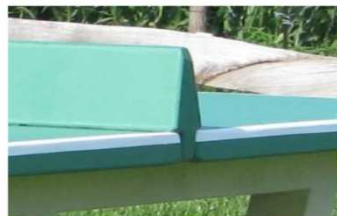
Filet béton incorporé au plateau (Arrachement ou vol impossible)
