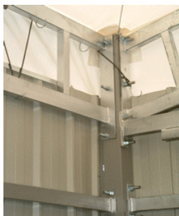
Détail structure intérieure
