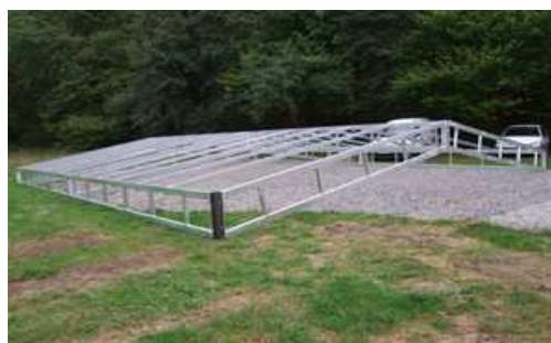
Détail échelles de côtés et pignons
