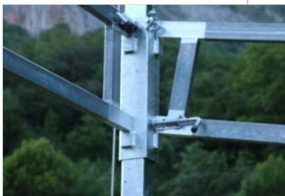
Partie coulissante pour relever la toiture + système de clavetage
