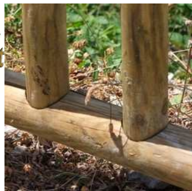
Détail emboitement des barreaux
