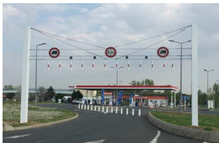
Portique a câble avec jalons, flashes et panneaux
