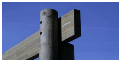
Détail fixation lisse
