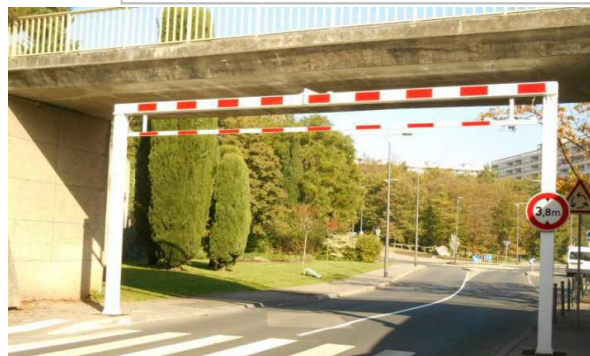
Portique avec option bavette simple et panneau limiteur de hauteur et support panneau
